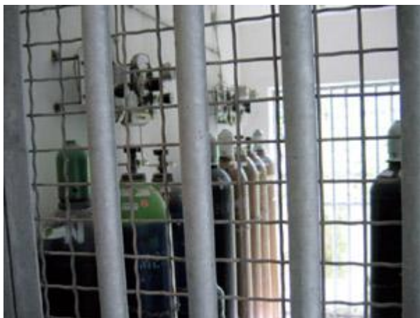
Abbildung 14: Gasentspannungsstation für Laborgase außerhalb des Laborraumes in einem gut gelüfteten Sonderraum
